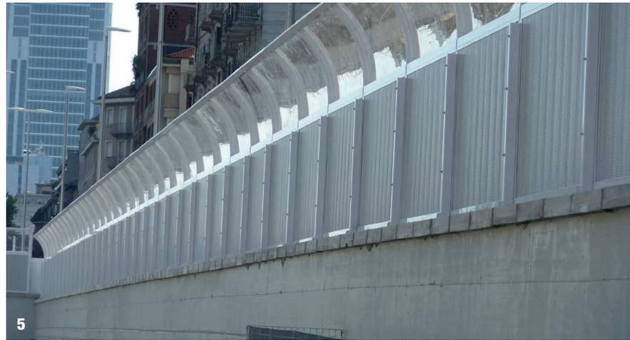
La classe di fonoisolamento codificata in base alla norma UNI EN 1793 spazia dalla Classe B1 alla Classe B3 (valore massimo previsto dalla norma), mentre i valori minimi di fonoisolamento variano da A3 ad A4 (valore massimo previsto dalla norma). Alcuni tipi di soluzioni prodotte:
